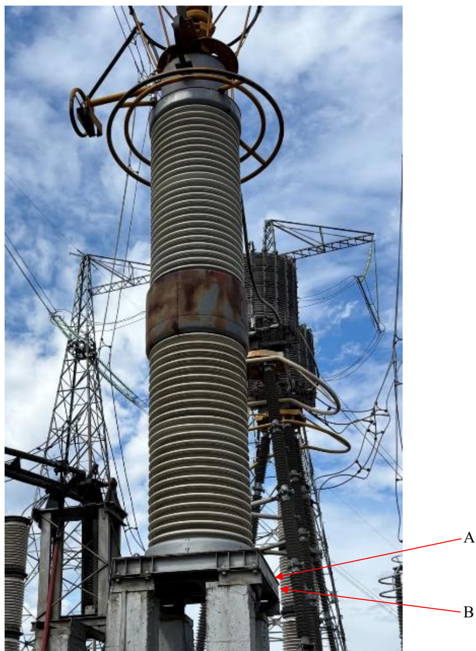
Рисунок 1 – Общий вид средства измерений, обозначение места пломбировки от несанкционированного доступа (А) и обозначение места нанесения заводских номеров (В)
