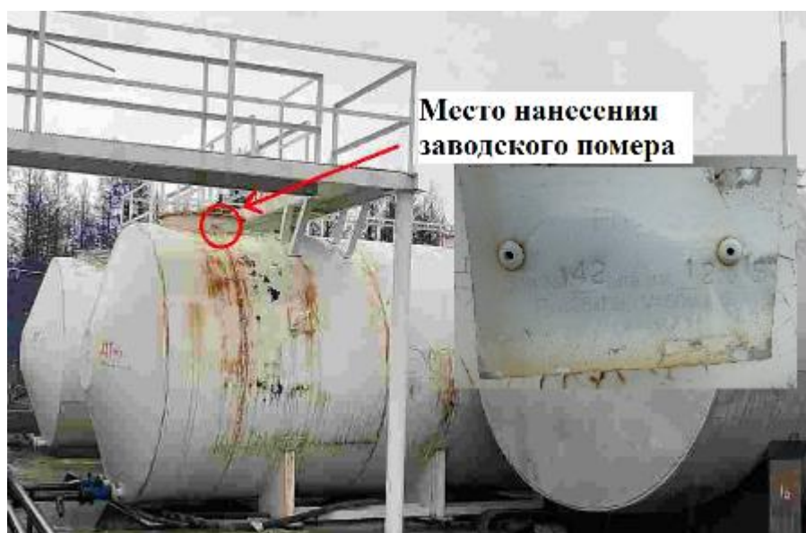
Рисунок 1 – Общий вид резервуара горизонтального стального цилиндрического РГС-50 с указанием места нанесения заводского номера
