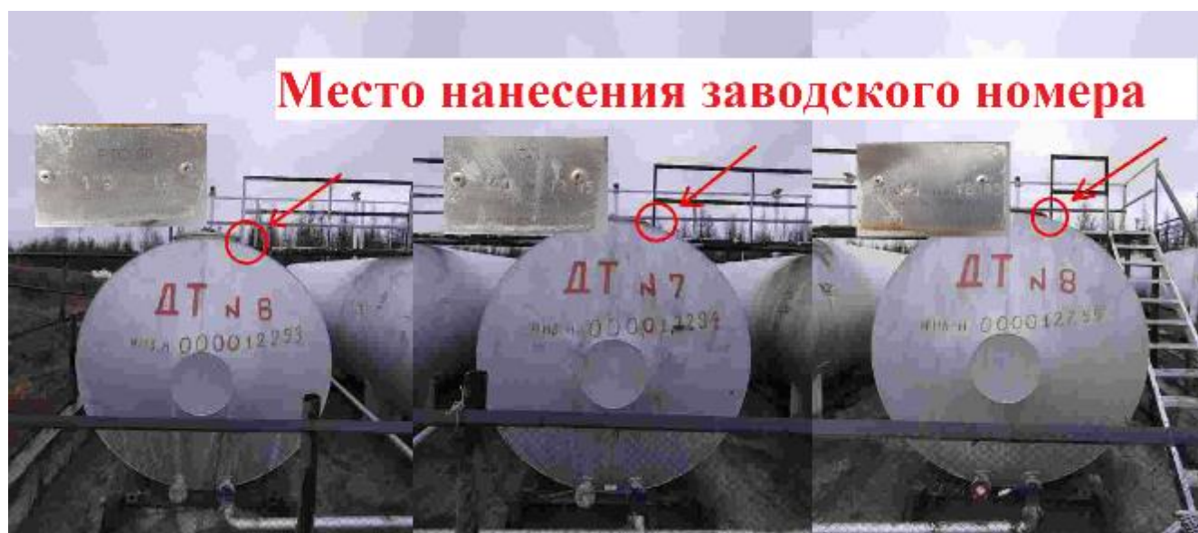
Рисунок 1 – Общий вид резервуара горизонтального стального цилиндрического РГС-50 с указанием места нанесения заводского номера
