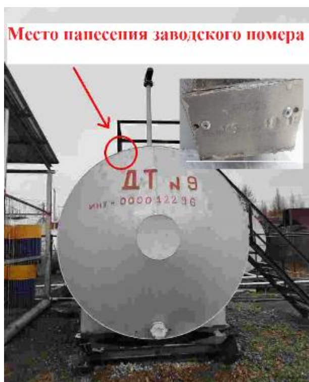
Рисунок 2 – Общий вид резервуара горизонтального стального цилиндрического РГС-25 с указанием места нанесения заводского номера
