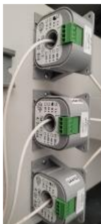
Рисунок 17 – Преобразователи силы тока измерительные ПИТ в месте установки
