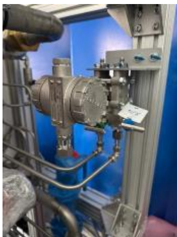
Рисунок 15 – Преобразователь давления измерительный АИР-20/М2 в месте установки
