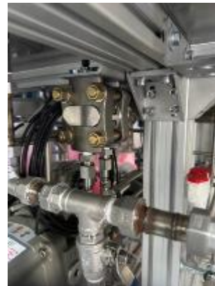
Рисунок 14 - Преобразователь разности давлений Корунд-ДД в месте установки
