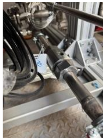
Рисунок 16 – Расходомер-счётчик жидкости РВШ-ТА в месте установки
