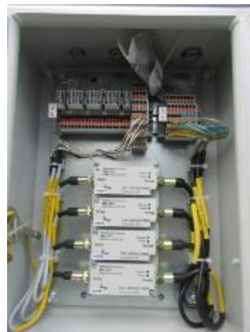
Рисунок 12 – Нормализаторы сигналов МЕ-402 в шкафу нормализаторов ШН2
