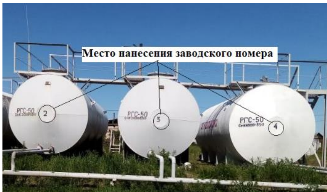
Рисунок 1 – Общий вид резервуара горизонтального стального цилиндрического РГС-50 с указанием места нанесения заводского номера
