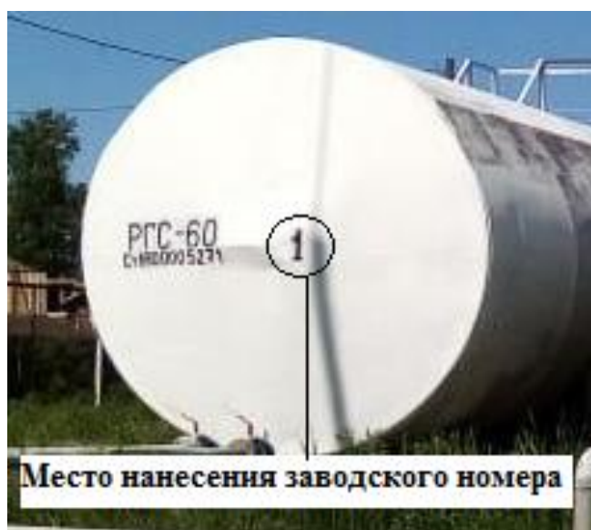
Рисунок 2 – Общий вид резервуара горизонтального стального цилиндрического РГС-60 с указанием места нанесения заводского номера
