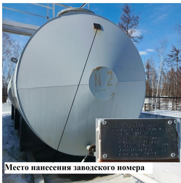
Рисунок 1 – Общий вид резервуара горизонтального стального цилиндрического РГС-50 с указанием места нанесения заводского номера
