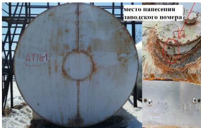
Рисунок 1 – Общий вид резервуара горизонтального стального цилиндрического РГС-25 с указанием места нанесения заводского номера
