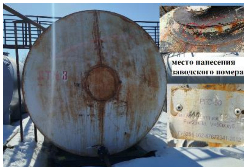
Рисунок 2 – Общий вид резервуара горизонтального стального цилиндрического РГС-50 с указанием места нанесения заводского номера
