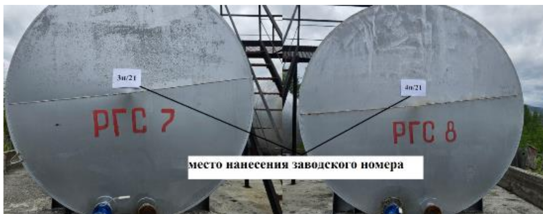
Рисунок 1 – Общий вид резервуаров горизонтальных стальных цилиндрических РГС-50 с указанием места нанесения заводских номеров
