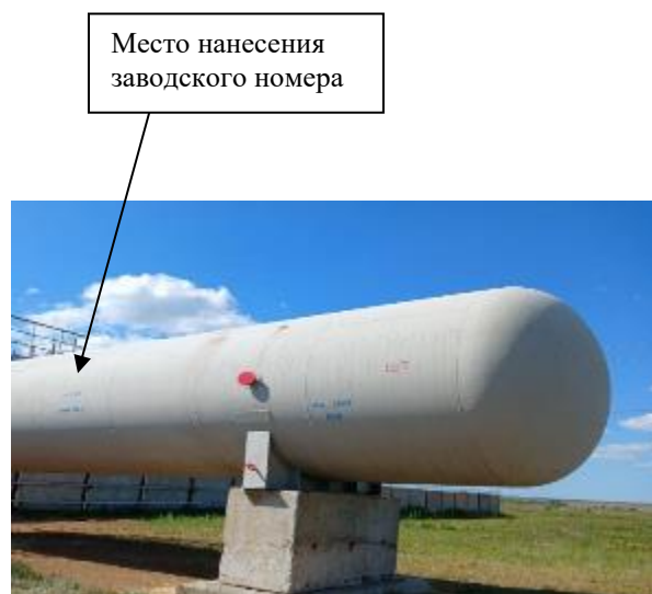
Рисунок 2 – Вид замерного люка и место нанесения заводского номера резервуара горизонтального стального РГС-100 заводской номер 1064
