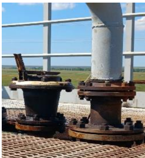
Рисунок 2 – Вид замерного люка и место нанесения заводского номера резервуара горизонтального стального РГС-100 заводской номер 1064
