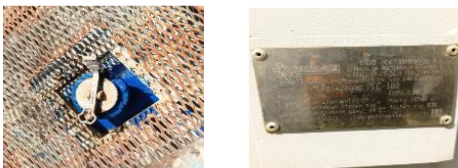
Рисунок 2 – Вид замерного люка и место нанесения заводского номера резервуара горизонтального стального РГС-100 заводской номер 9318/1
