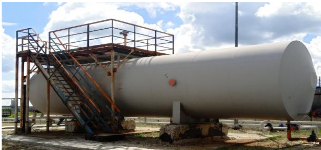
Рисунок 1 – Общий вид резервуара горизонтального стального РГС-100 заводской номер 9318/1
