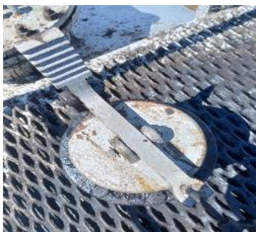
Рисунок 2 – Вид замерного люка и место нанесения заводского номера резервуара горизонтального стального РГС-72 заводской номер 1
