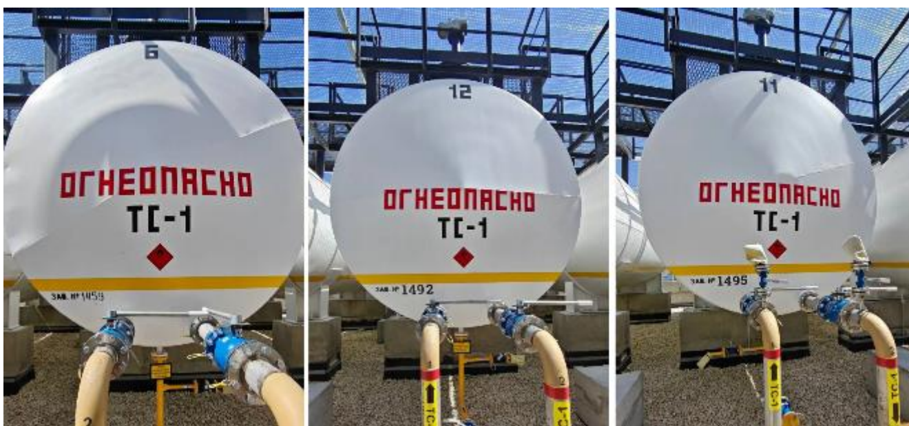
Рисунок 4 – Общий вид резервуаров РГС-50 с зав.№№ 1459, 1492, 1495
