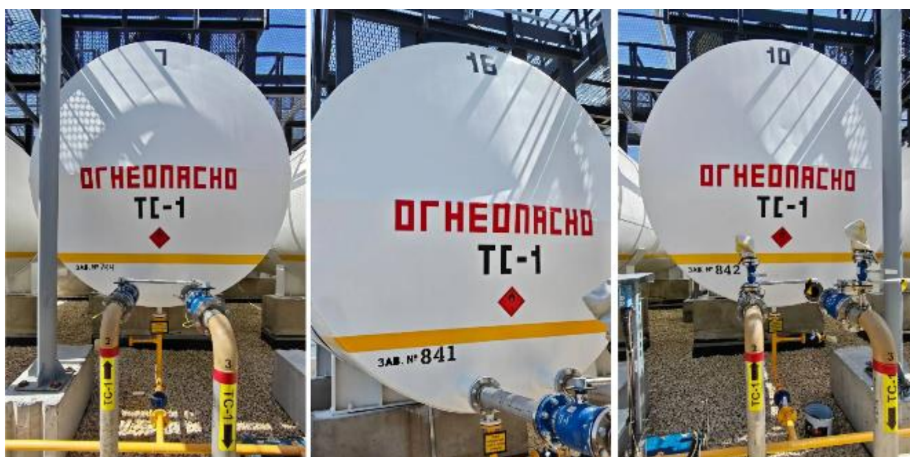
Рисунок 2 – Общий вид резервуаров РГС-50 с зав.№№ 744, 841, 842
