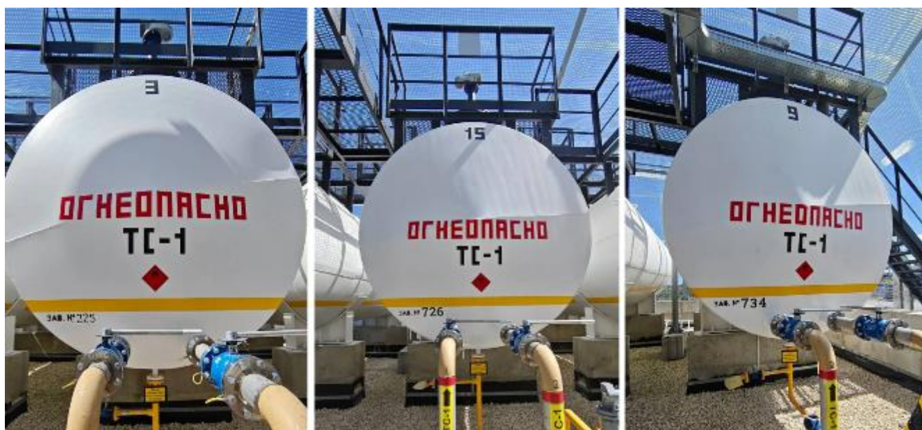
Рисунок 1 – Общий вид резервуаров РГС-50 с зав.№№ 225, 726, 734
