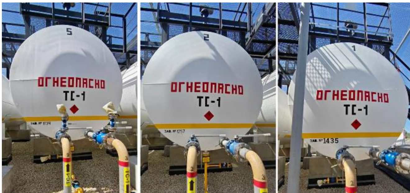
Рисунок 3 – Общий вид резервуаров РГС-50 с зав.№№ 1134, 1257, 1435
