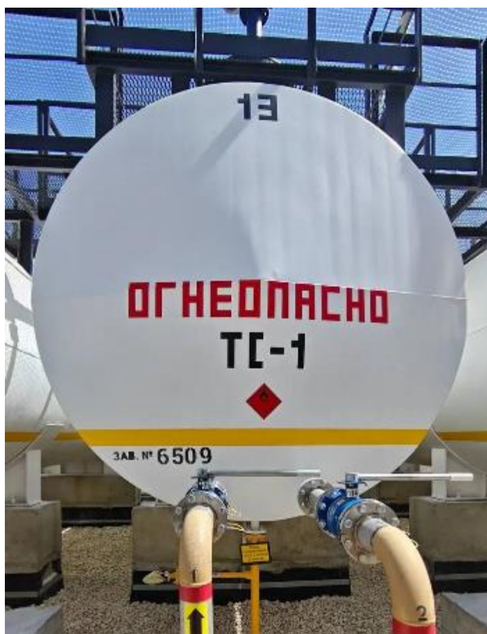
Рисунок 6 – Общий вид резервуара РГС-50 с зав.№ 6509
