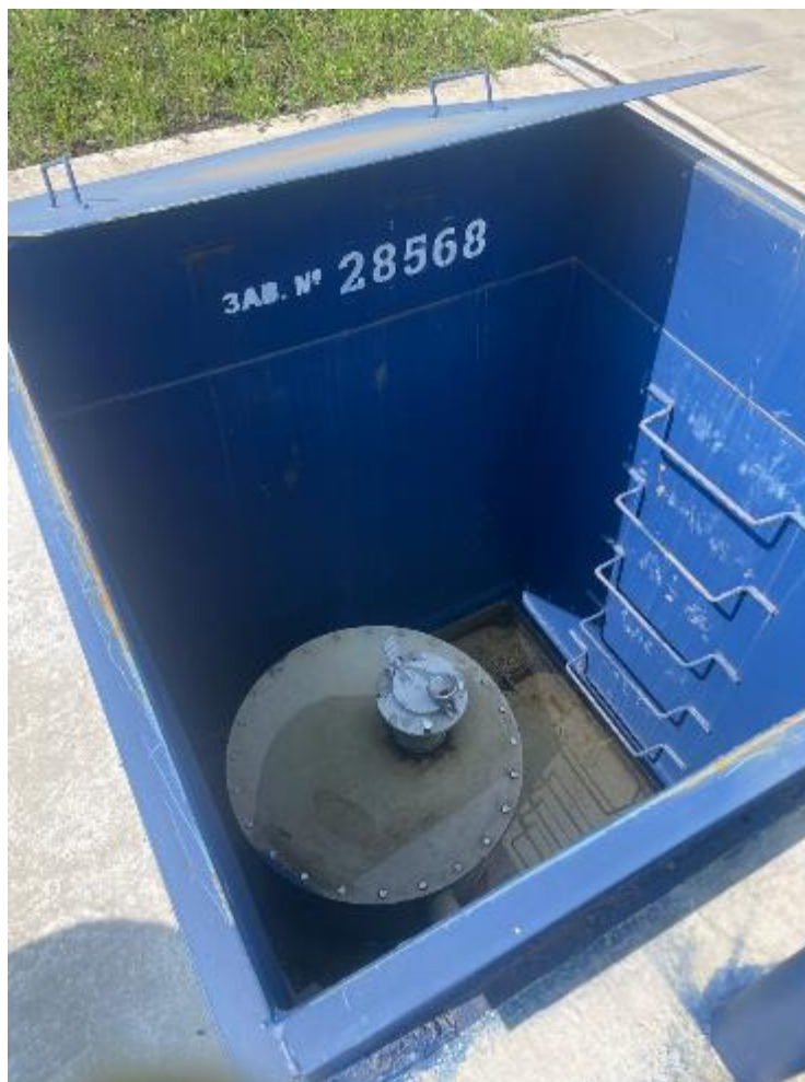
Рисунок 2 – Горловина резервуара РГС-40 зав.№ 28568
