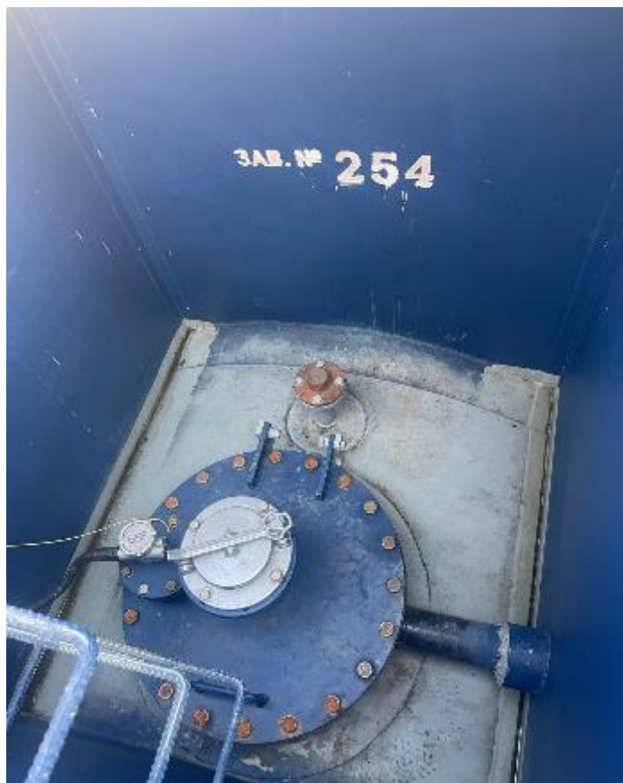
Рисунок 2 – Горловина резервуара РГС-25 зав.№ 254
