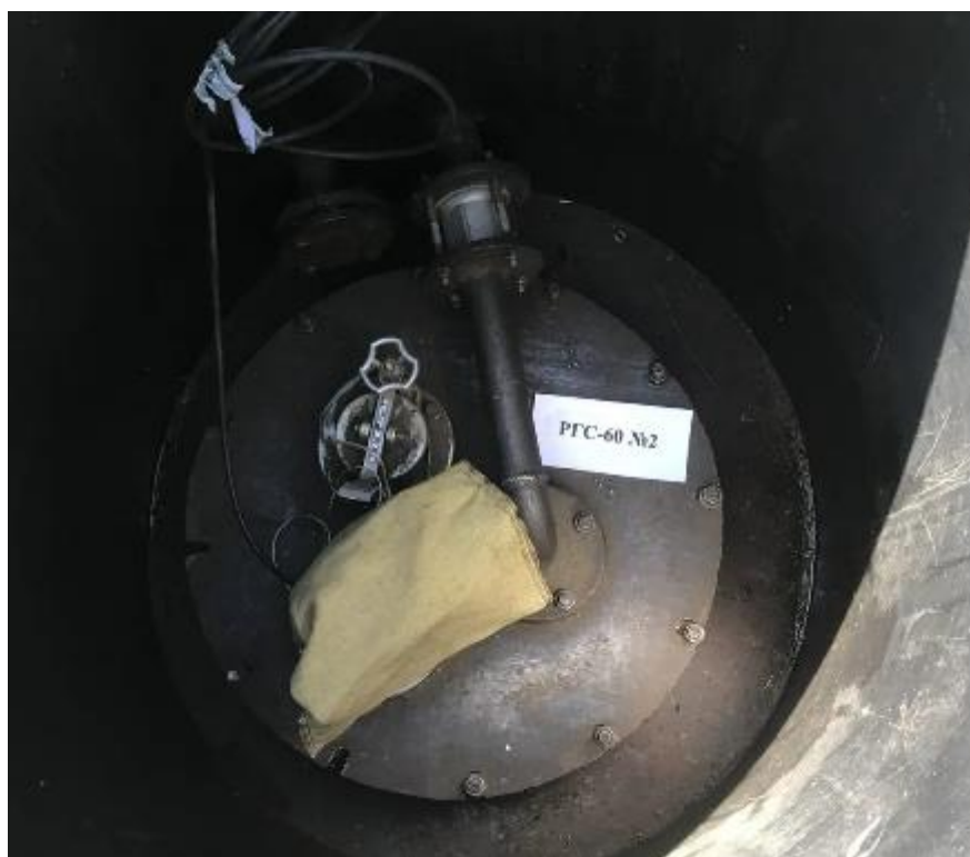
Рисунок 3 – Горловина резервуара РГС-60 зав.№ 2
