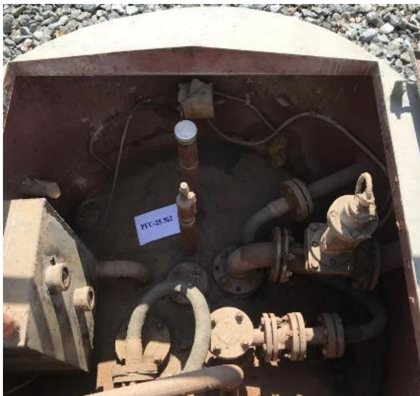
Рисунок 3 – Горловина резервуара РГС-25 зав.№ 2
