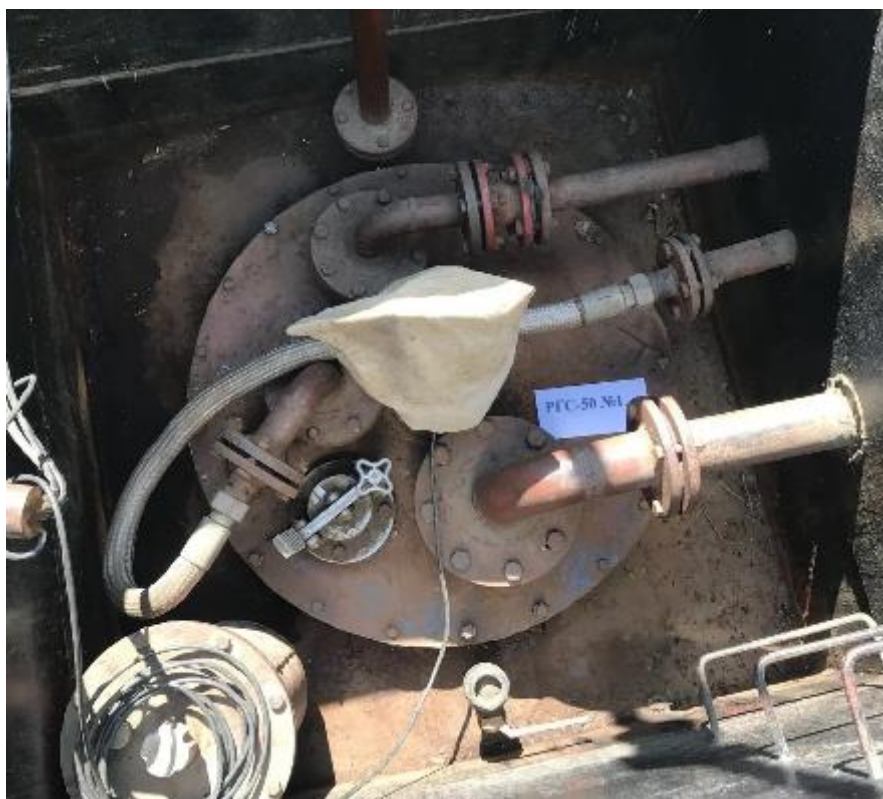
Рисунок 4 – Горловина резервуара РГС-50 зав.№ 1
