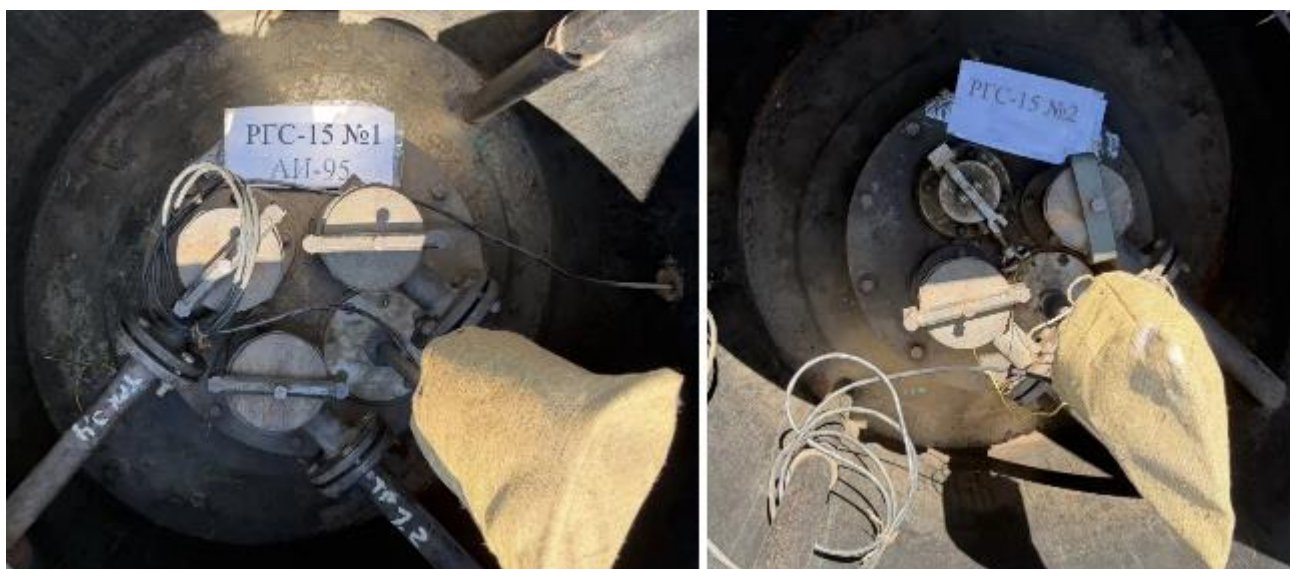
Рисунок 2 – Горловины резервуаров РГС-15 зав.№№ 1, 2
