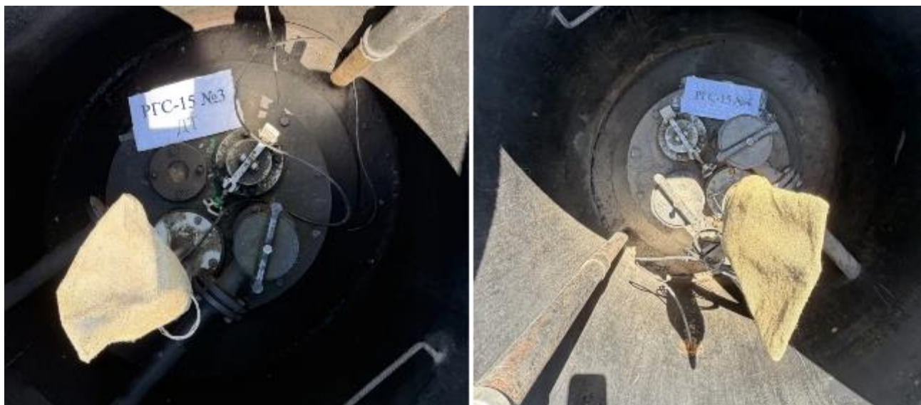
Рисунок 3 – Горловины резервуаров РГС-15 зав.№№ 3, 4
