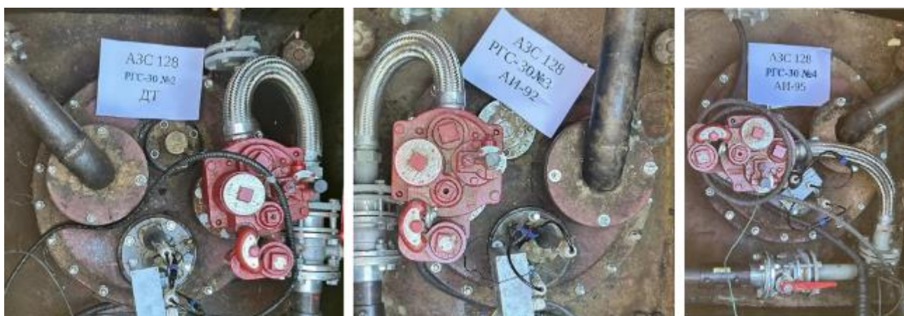
Рисунок 3 – Горловины резервуаров РГС-30 зав.№№ 2, 3, 4
