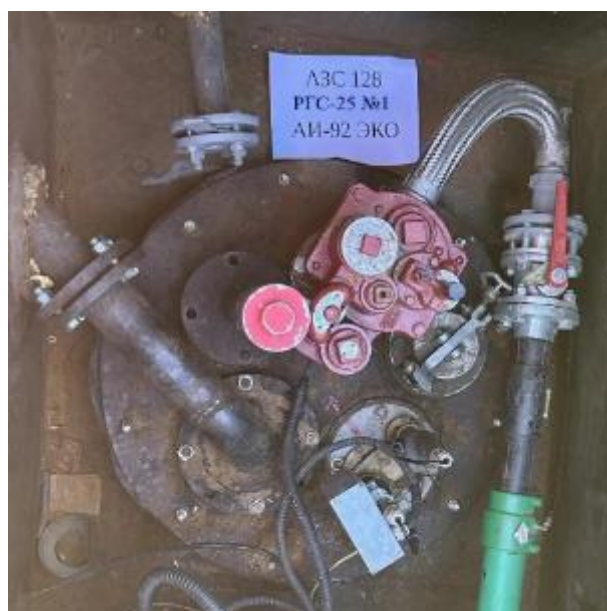
Рисунок 2 – Горловина резервуара РГС-25 зав.№ 1
