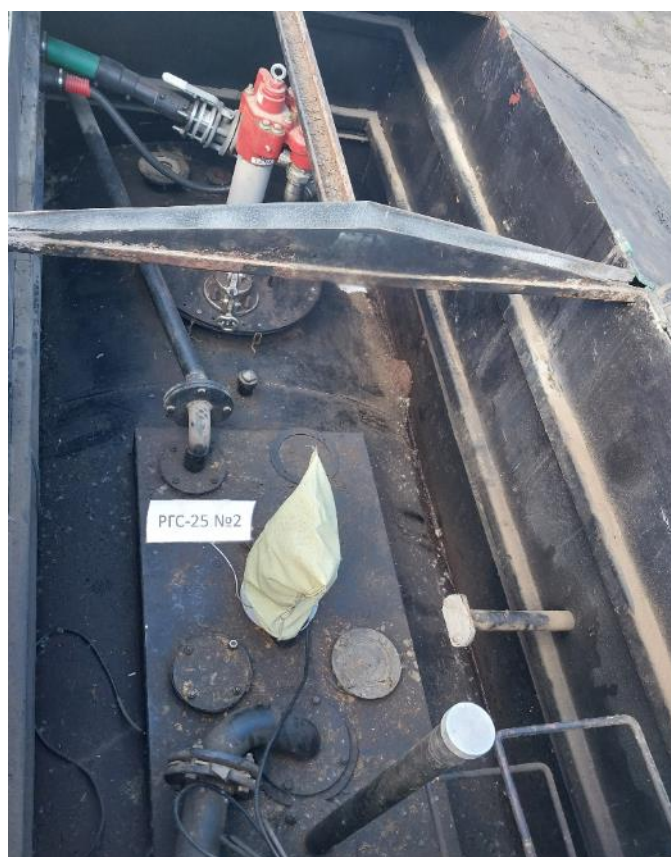
Рисунок 3 – Горловины резервуара РГС-25 зав.№ 2
