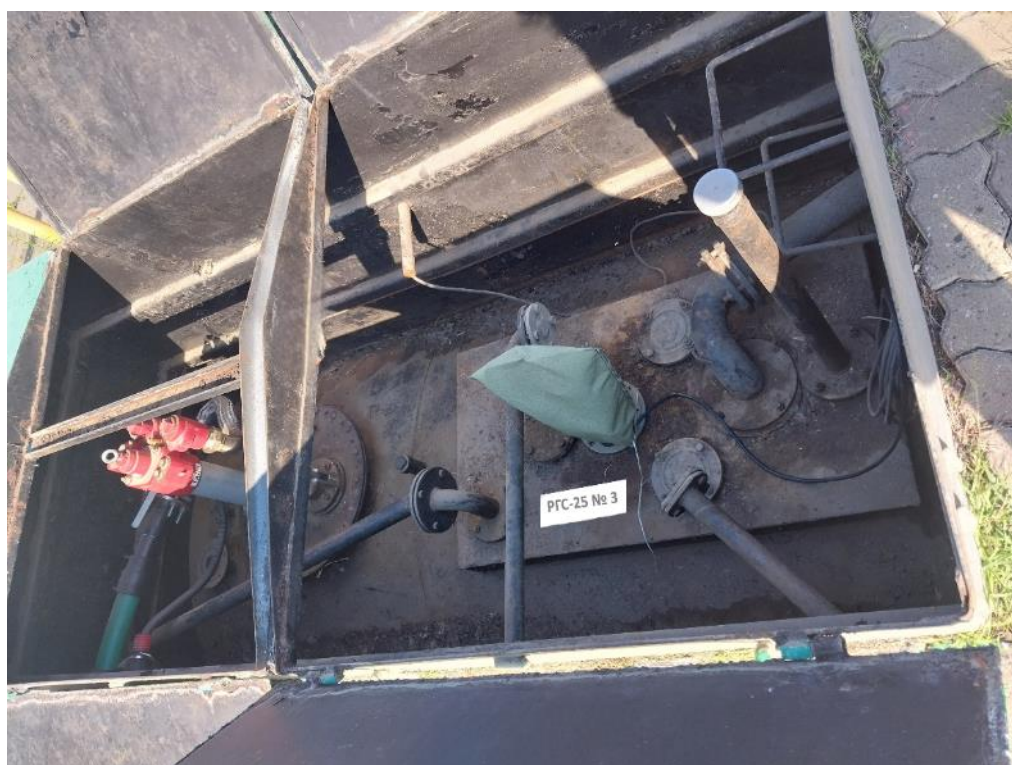
Рисунок 4 – Горловины резервуара РГС-25 зав.№ 3
