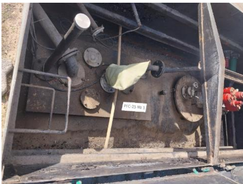
Рисунок 2 – Горловины резервуара РГС-25 зав.№ 1
