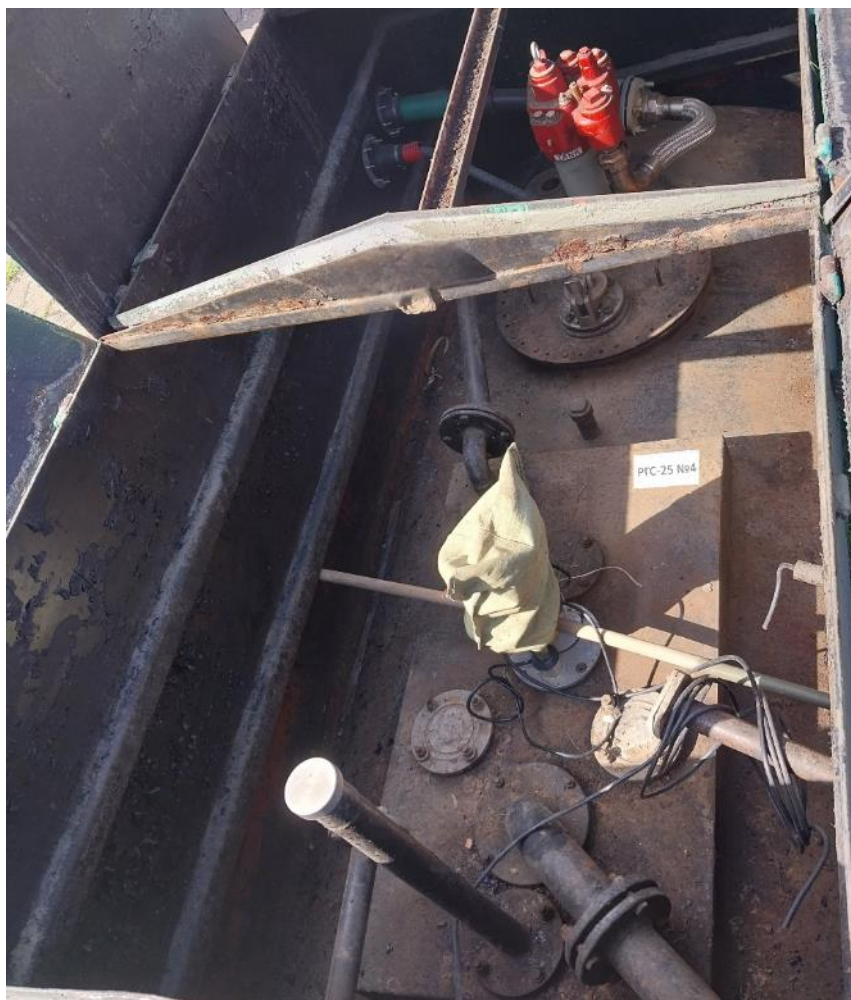
Рисунок 5 – Горловины резервуара РГС-25 зав.№ 4
