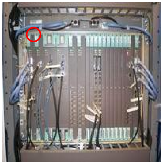
Рисунок 2 Место блокировки кассетного модуля (выделено)
