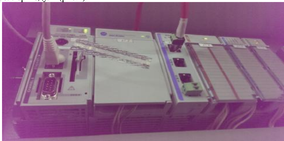
Рис. 2. Место опломбирования модуля измерительного.
