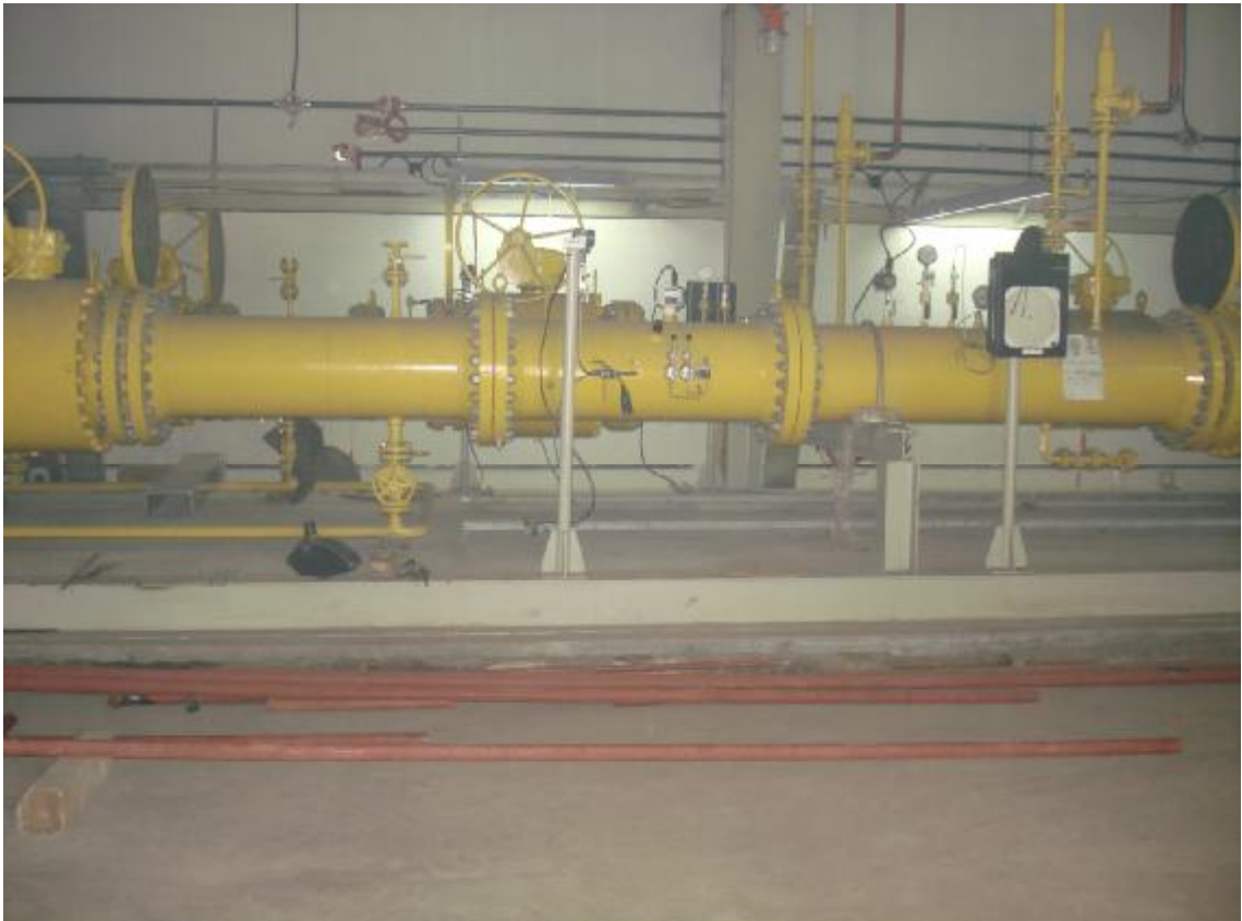
Рис. 1 - внешний вид Системы измерительной коммерческого учета газа энергоблока № 8 ТЭЦ-26 ОАО «Мосэнерго» (СИКГ).
