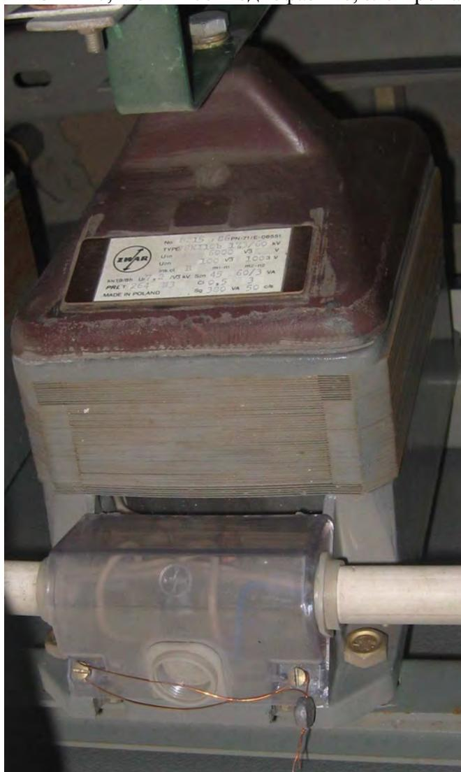
Магнитопровод трансформаторов стержневого типа, обмотки расположены concentрически. Основная вторичная обмотка предназначена для измерения и учета электроэнергии, дополнительная вторичная обмотка – для защиты, питания цепей автоматики, управления, сигнализации или для контроля изоляции сети.
