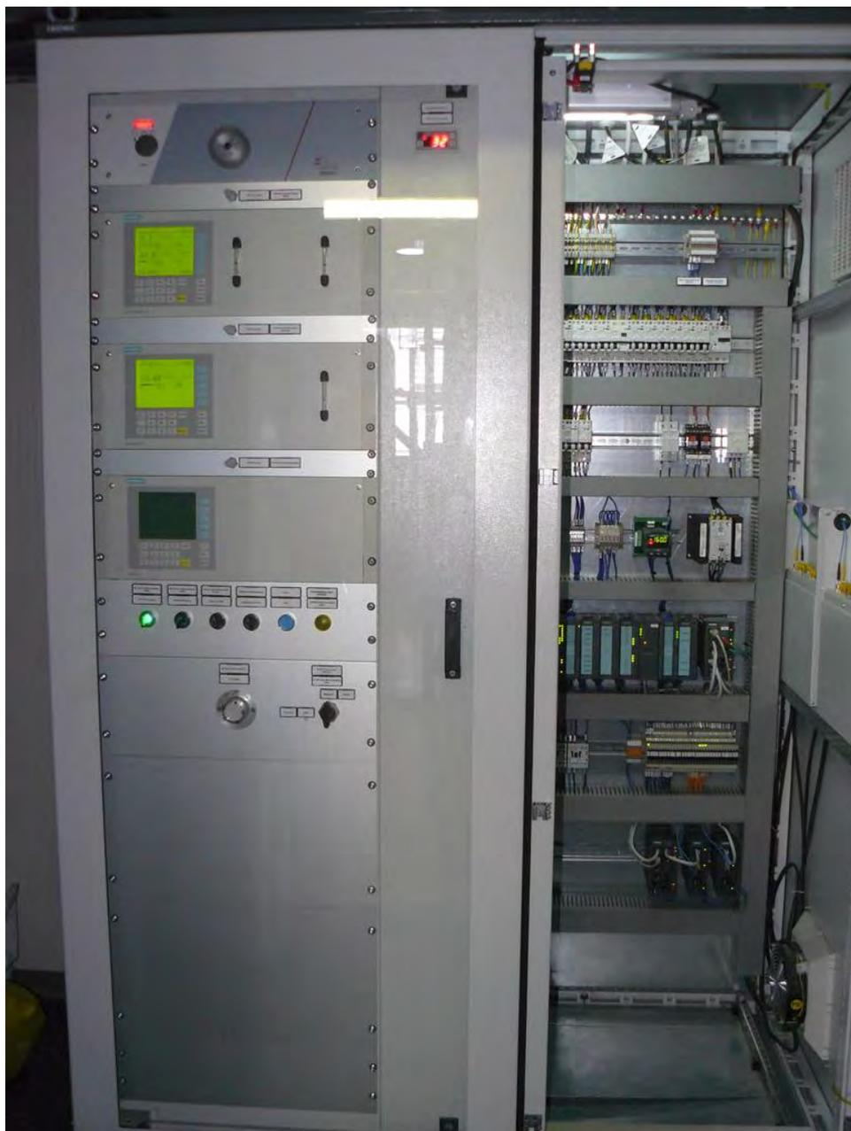
Рисунок 1 – Внешний вид шкафа системы газового анализа с установленными газоанализаторами
