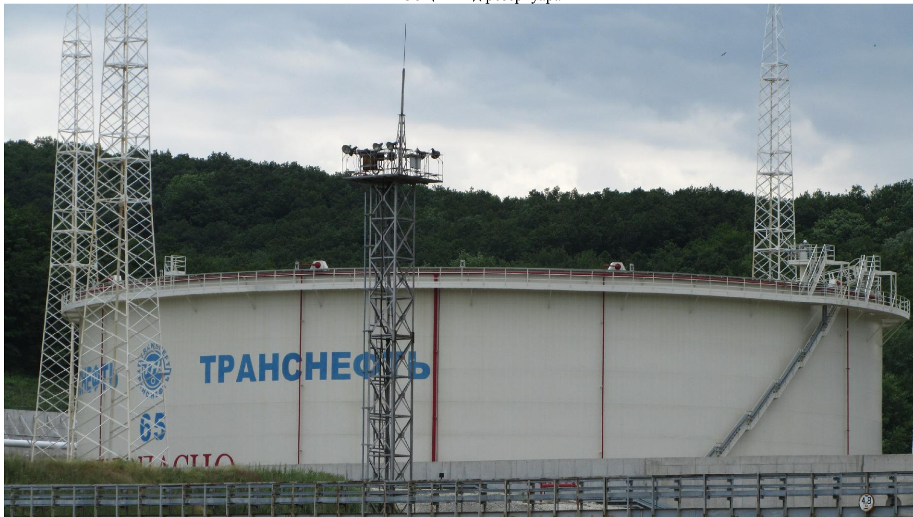
Общий вид резервуара
