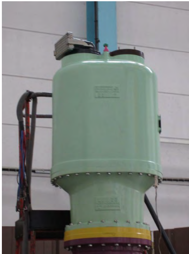
Внешний вид трансформатора напряжения UDP 245 и место пломбирования
