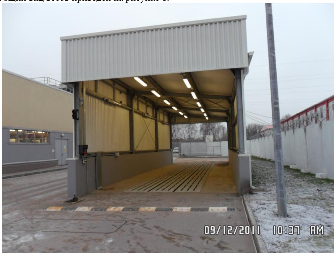
Рисунок 1- Общий вид весов автомобильных MSW
