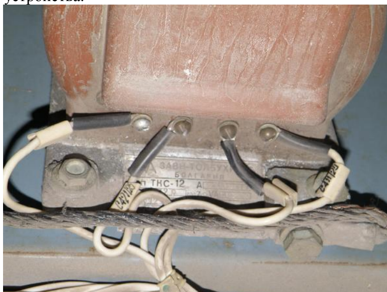
Рисунок 1. Трансформатор тока ТКС-12
