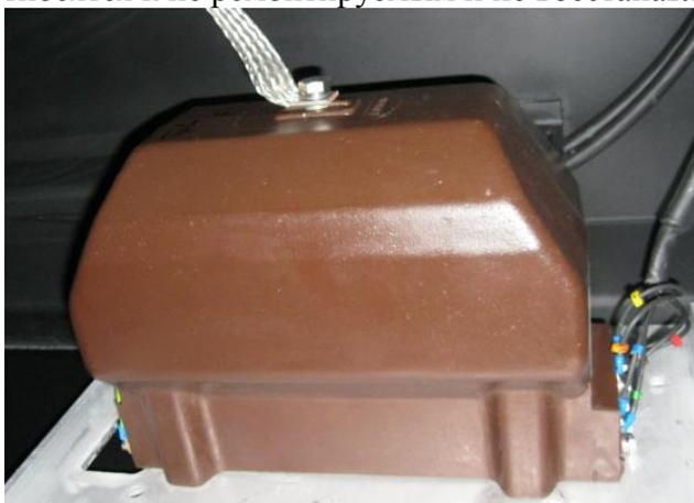
Первичные и вторичные обмотки залиты компаундом, который обеспечивает основную изоляцию и формирует корпус трансформатора. Выводы первичной обмотки выведены на верхнюю часть литого корпуса в виде контактных площадок с двумя отверстиями для болтов М12. Вторичные обмотки выведены в литую коробку для зажимов, закрытую пластмассовой крышкой и расположенную у основания трансформатора на узкой боковой стенке. Крышка,
