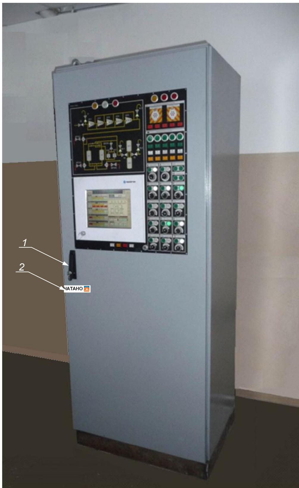
1 – ручка шкафа с механическим замком; 2 - разрушаемая шильд-наклейка.
