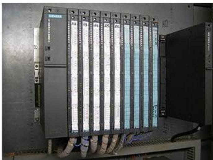
Рисунок 2 - Программируемый контроллер Simatic S7-400
