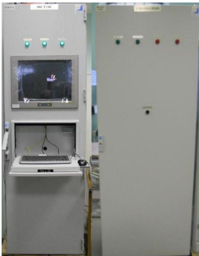
ШУ ПТК УМД является совокупностью контроллеров, обеспечивающих сбор и обработку электрических сигналов, полученных от первичных датчиков и информационный обмен с АРМ ОП.
