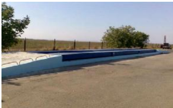
Рис. 1 - Установка ГПУ весов на поверхности дорожного полотна
