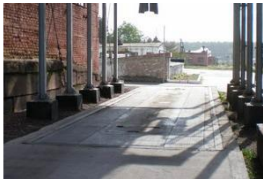
Рис. 2 – Установка ГПУ весов в приямок
