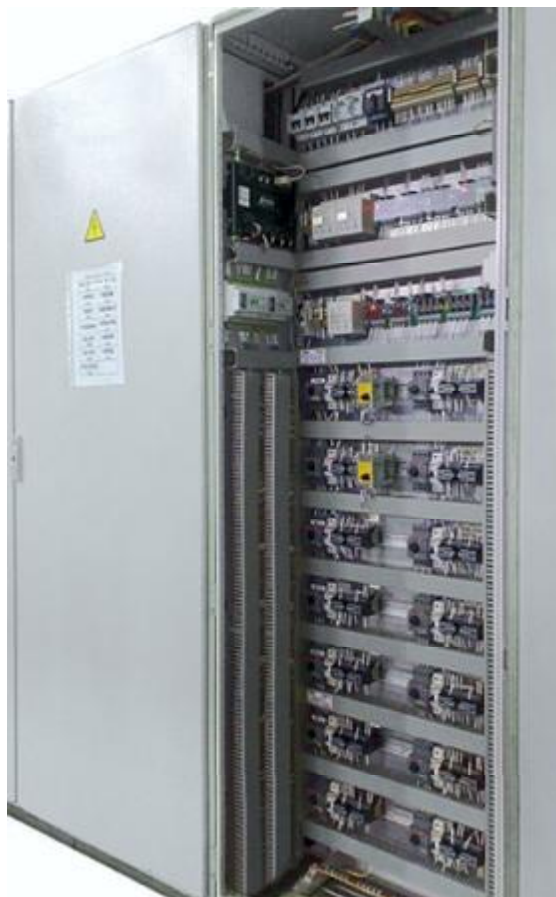
Рисунок 1 – общий вид аппаратного шкафа ПТК «САРГОН»
