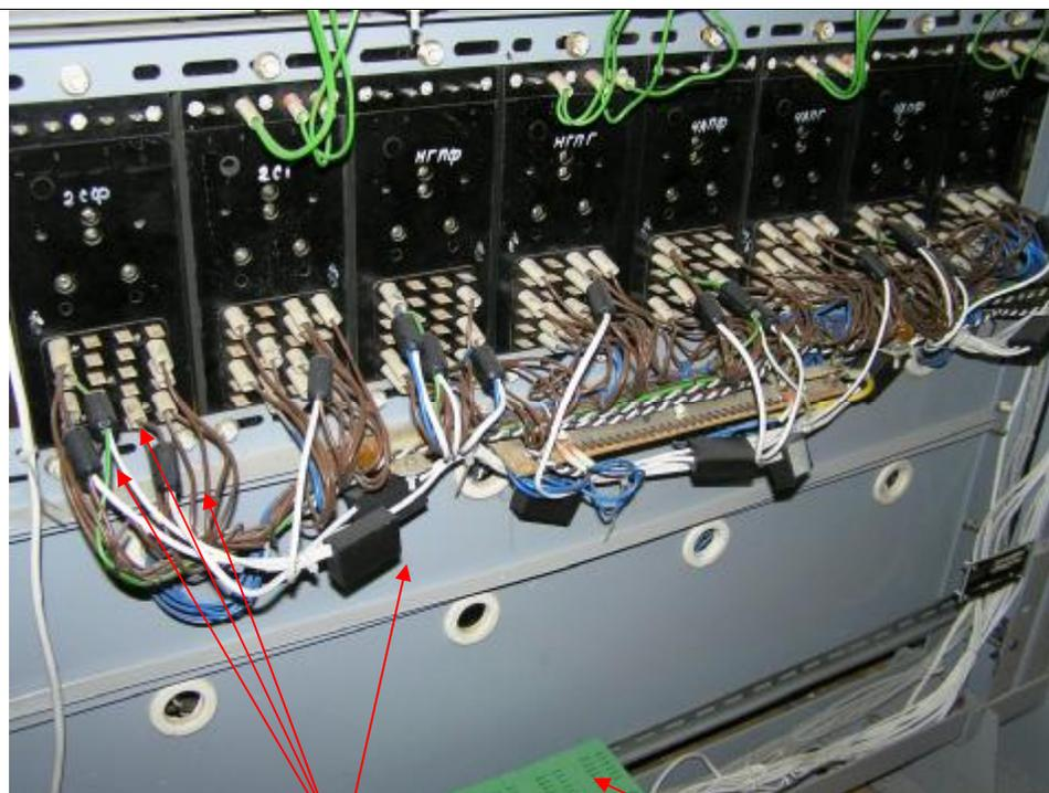
Рисунок 2 – Показано размещение датчиков контроля напряжения на генераторах и фильтрах тональных рельсовых цепей. Снятый аналоговый сигнал предварительно обрабатывается и преобразуется в «цифру».
