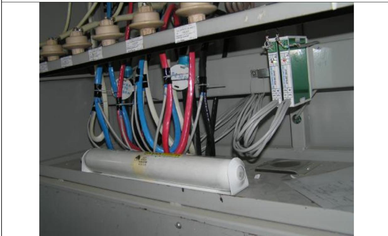
Рисунок 4 – Размещение функциональных модулей БТ05-007-04 измерения напряжения фаз фидера 0,4 кВ в вводном шкафу.
