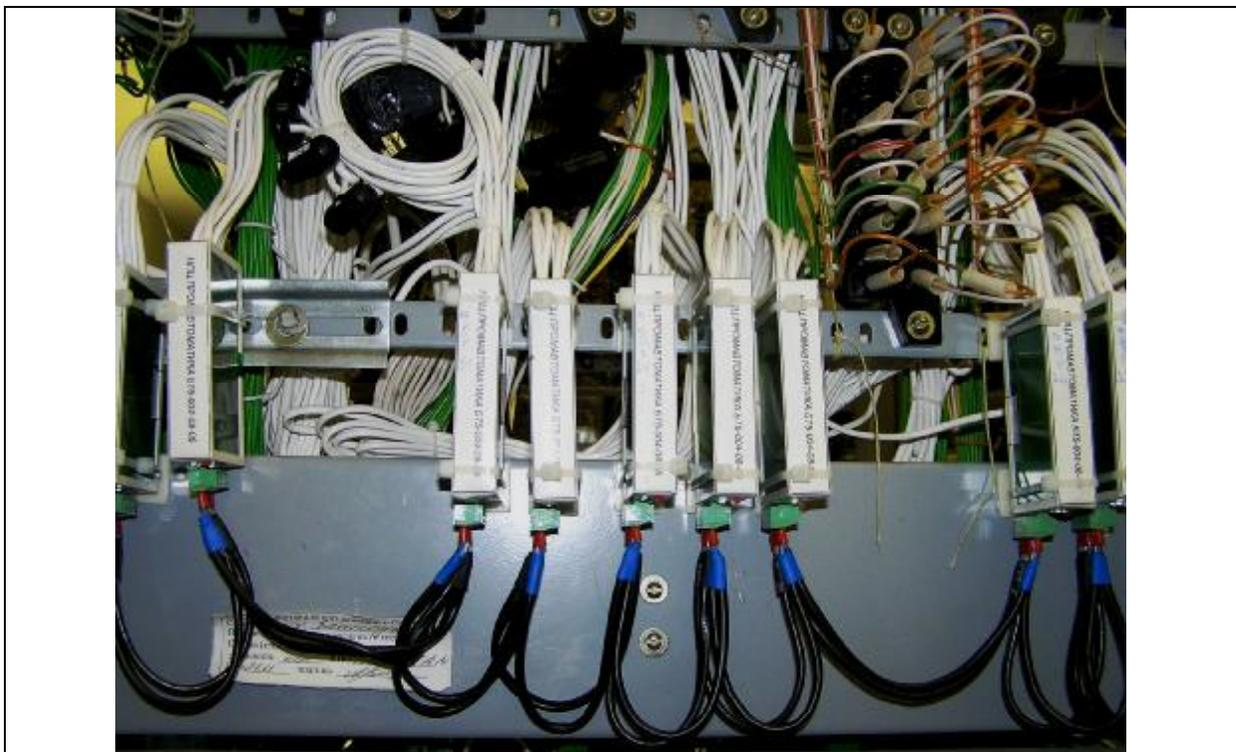
Рисунок 3 – Размещение функциональных модулей БТ05-004-08 измерения тока на станине.
