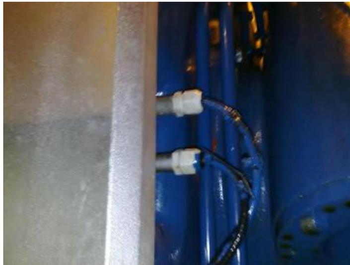
Рисунок 1. Общий вид датчика частоты вращения магнитного JAQUET DSE 1810.13 АНЗ
