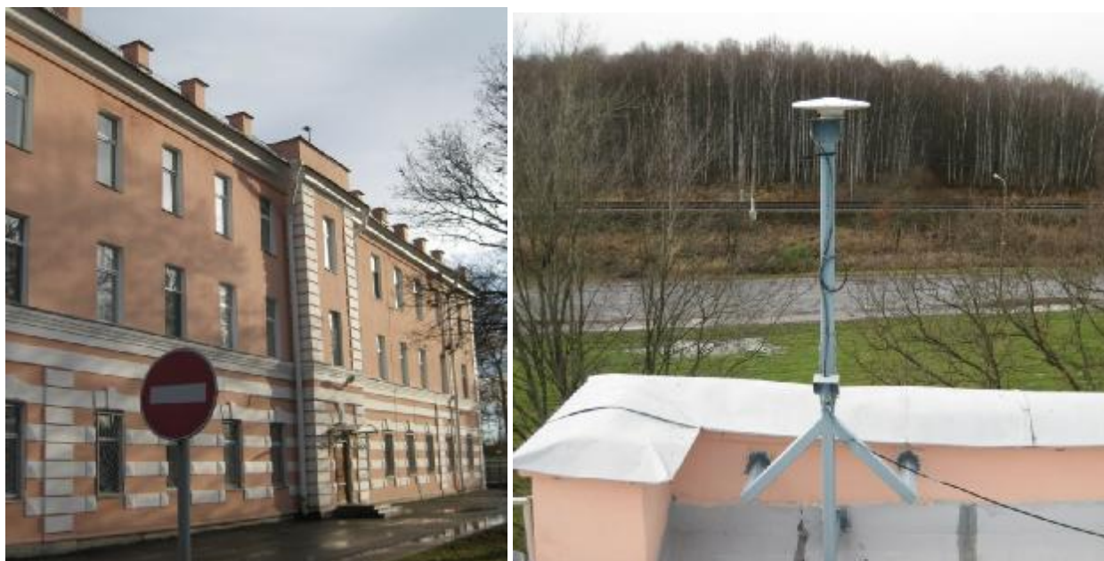
Рисунок 5 – Внешний вид реперного пункта, расположенного по адресу: г. Пушкин, ш. Филътровское, д. 7
