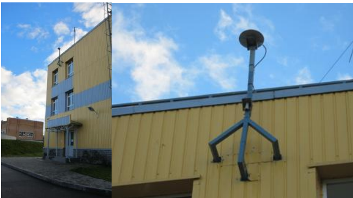
Рисунок 2 – Внешний вид реперного пункта, расположенного по адресу: г. Петродворец, ш. Ораниенбаумское д.1 Лит. А
