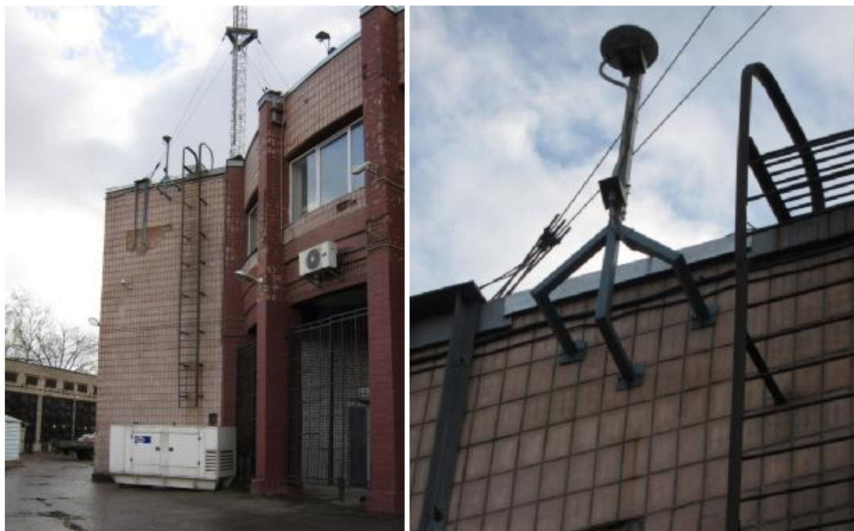
Рисунок 7 – Внешний вид реперного пункта, расположенного по адресу: г. Санкт-Петербург, наб. Октябрьская, д. 2
