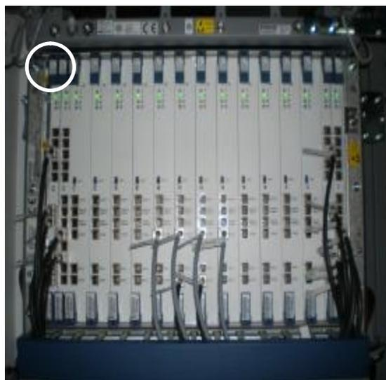
Рисунок 2- место блокировки кассет
