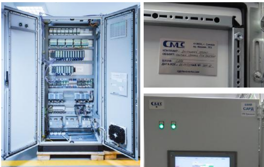
Рисунок 1 Фотографии общего вида и маркировки шкафов комплексов программно-технических SIMATIC PCS7 «Трансконт»
