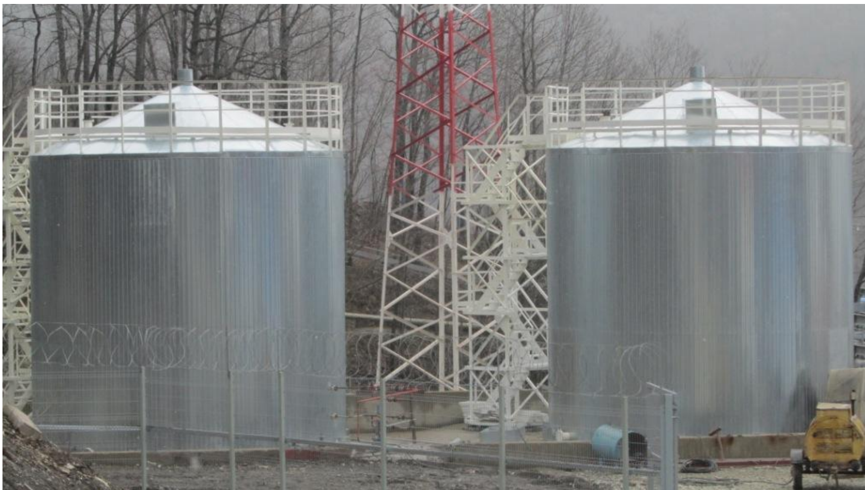
Рисунок 1. Общий вид резервуаров
