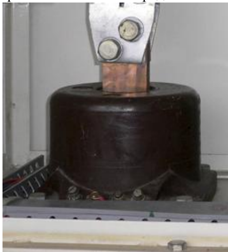
Рисунок 1 – Фотографии общего вида трансформаторов тока JPZ102TA.
