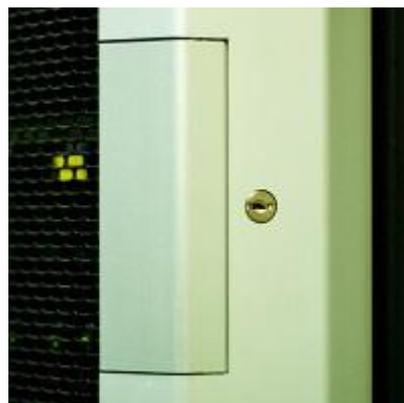
Рисунок 2 - Замок передней двери шкафа
