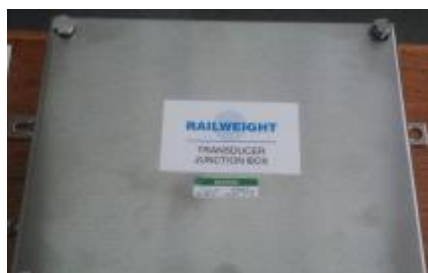
Рисунок 8 – Схема пломбировки соединительной коробки от несанкционированного доступа.
