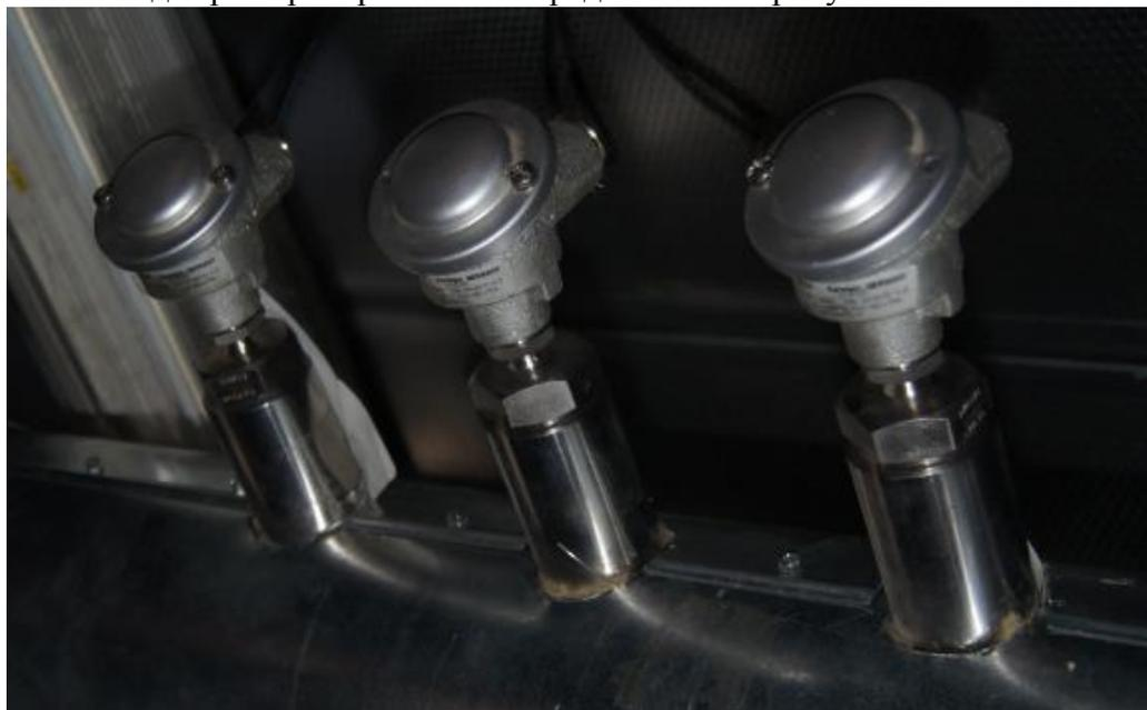
Рис. 1. Внешний вид термопреобразователя сопротивления платинового модели 2Pt100/В/2 исполнения 31151621.
