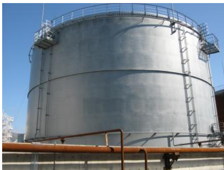
Рисунок 1. Общий вид резервуаров
