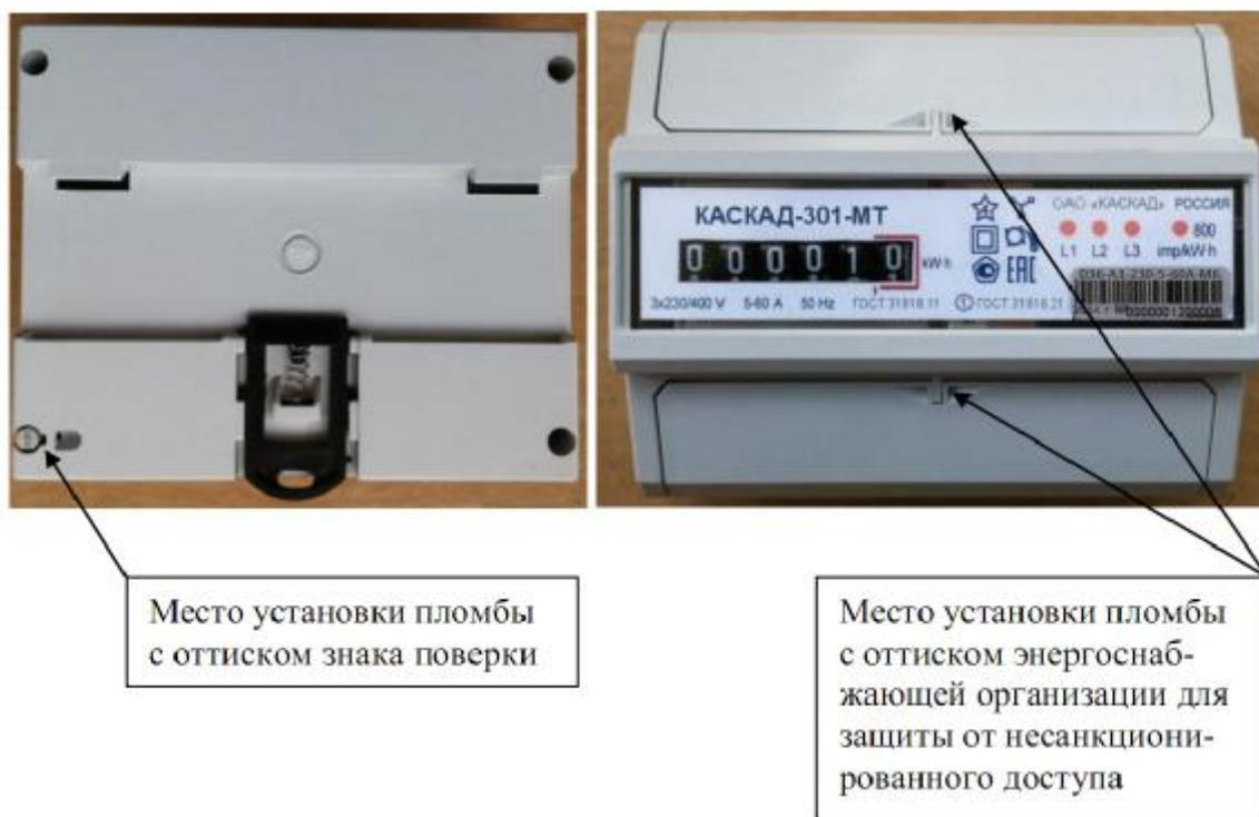
Рисунок 7 – Общий вид счетчика в корпусе типа D36
