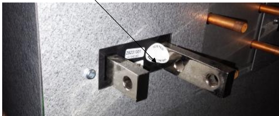
Рисунок 2 - Места опломбирования ИК модулей
