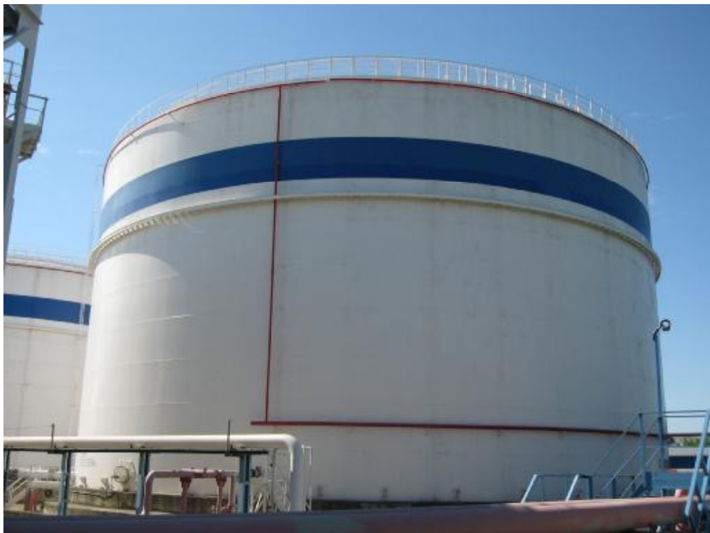
Рисунок 1. Общий вид резервуаров
