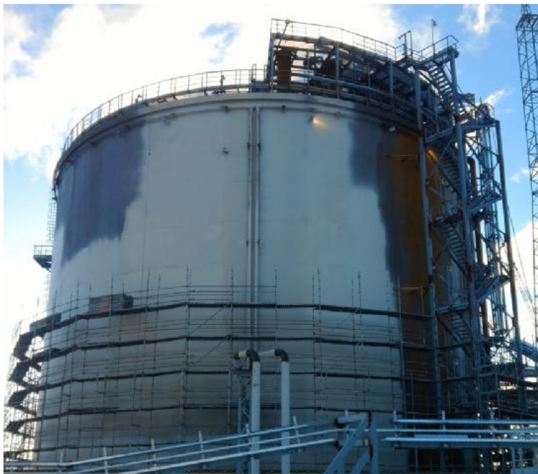
Рисунок 1 – Общий вид резервуара Е-7
