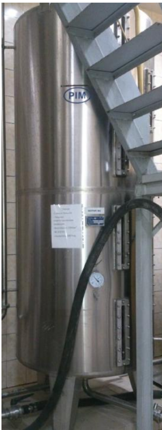
Рисунок 4. Общий вид мерника V=2,5 \text{ м}^3 № 5166.038
