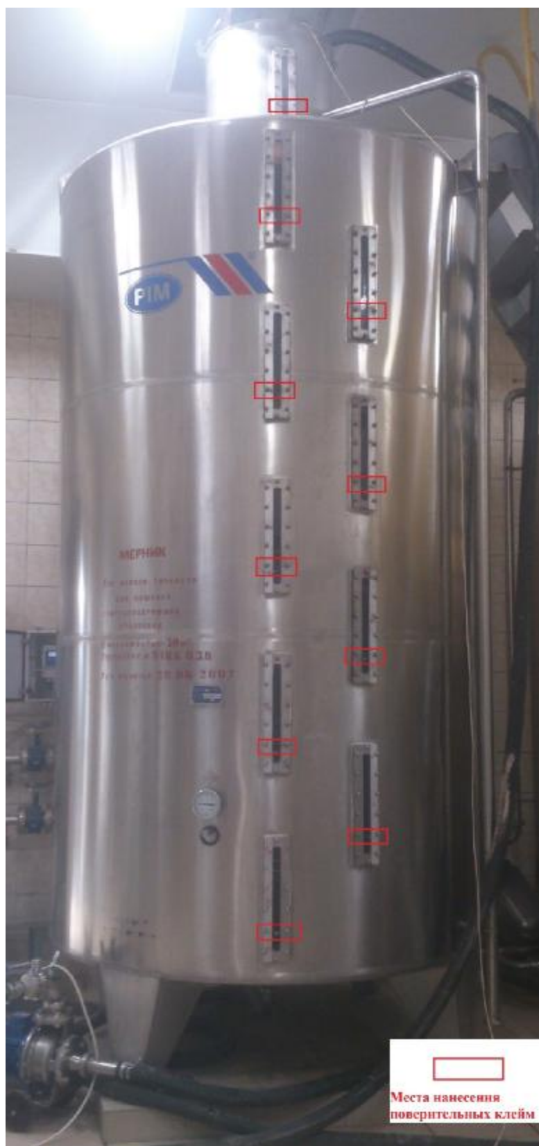
Рисунок 9. Места нанесения поверительных клейм мерника V=10 \text{ м}^3
